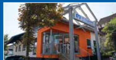
Elzebachstraße 2, 36214 Nentershausen Tel. 06627 9204-0
