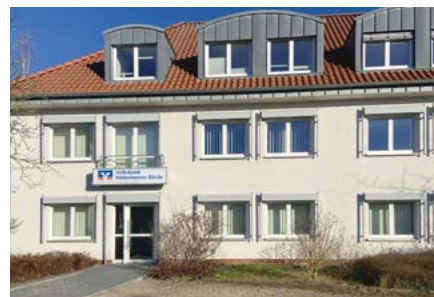
Das Ausweichquartier in der Grebstraße
