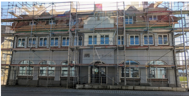
Das Bankgebäude unserer Geschäftsstelle in Gerzen während der Sanierung.
