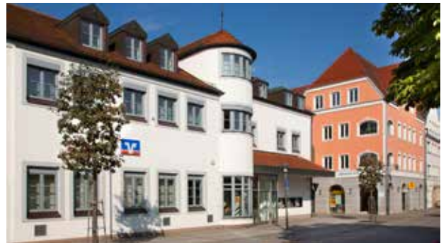
Umfassende Umbau- und Renovierungsarbeiten werden in der Hauptgeschäftsstelle Geisenhausen im Jahr 2022 umgesetzt
