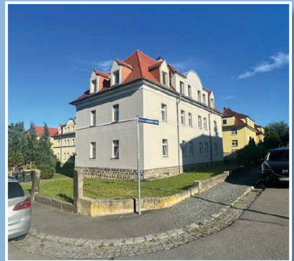
Neue Fassade in der Beyerstraße 9 & 20
