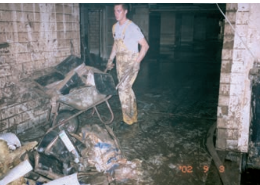
Aufräumarbeiten im Keller der Volksbank.
