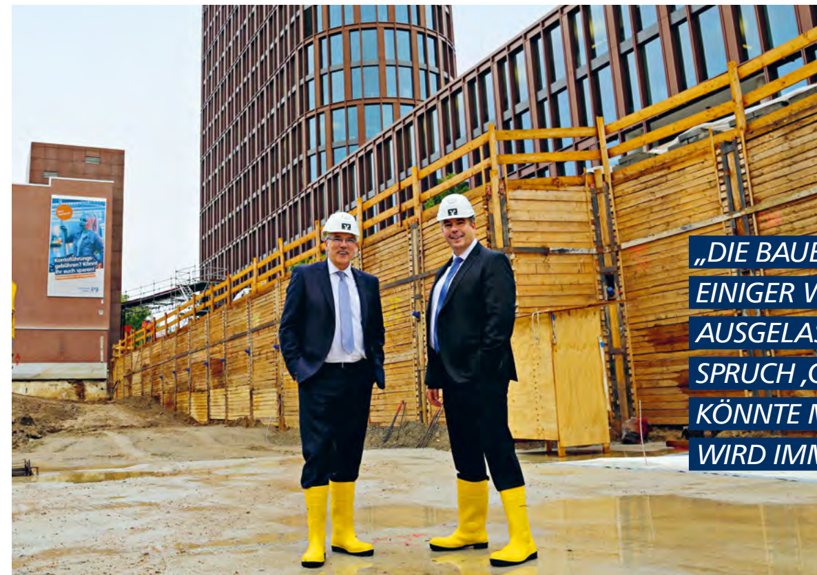
Die Geschäftsführer der BraWoBau GmbH Ulf Müller (l.) und Sven Krause auf der Baustelle des Business Centers III im BraWoPark
