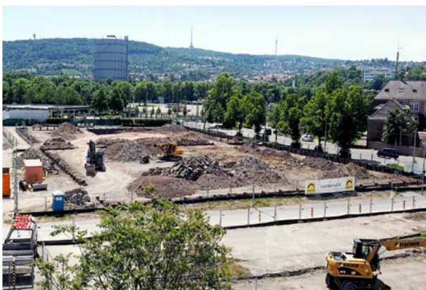
Vorher: Auf dem Gelände des ehemaligen Güterbahnhofs in Stuttgart-Bad Cannstatt entsteht der neue Firmensitz der Volksbank Stuttgart eG.
