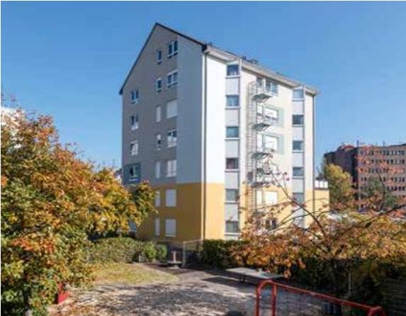
Frankfurt am Main Heisterstr.
