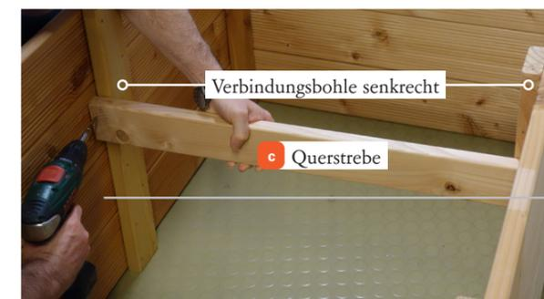
Querstrebe mit 2 Stück Holzschrauben 5 x 50 mm an Verbindungsbohlen verschrauben
