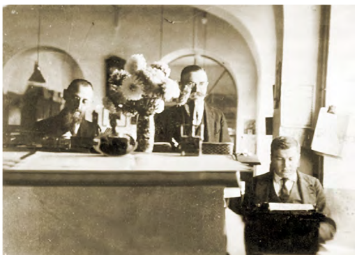
Arbeit am Schalter 1920.
