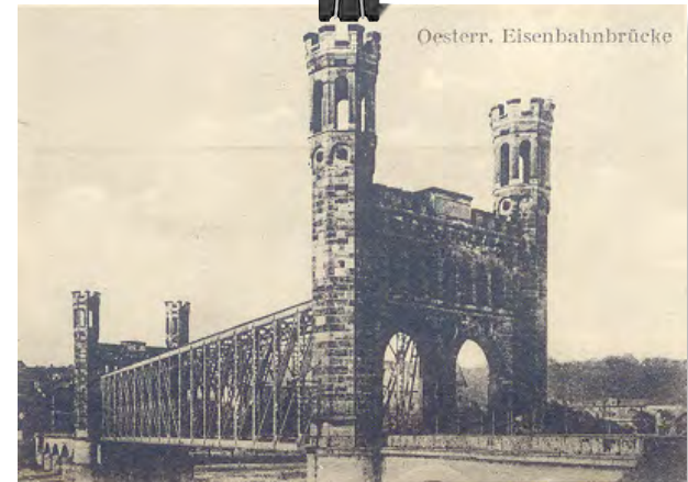
Die Eisenbahnbrücke mit vier Türmen.
