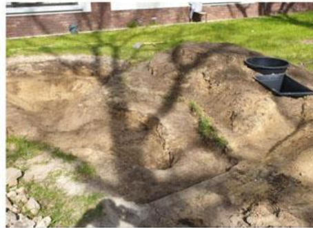
Der Aushub wird für den Bau der Kräuterspirale und des Filterteichs genutzt.
