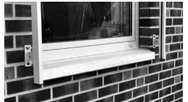
und Naturstein-Fensterbänke wurden wiederverwendet.
