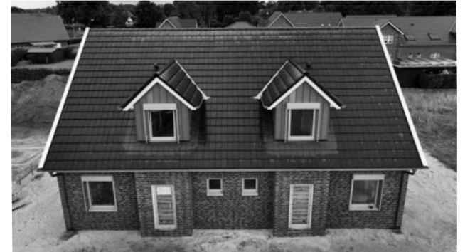
Dachziegel wurden erneut verbaut ...
