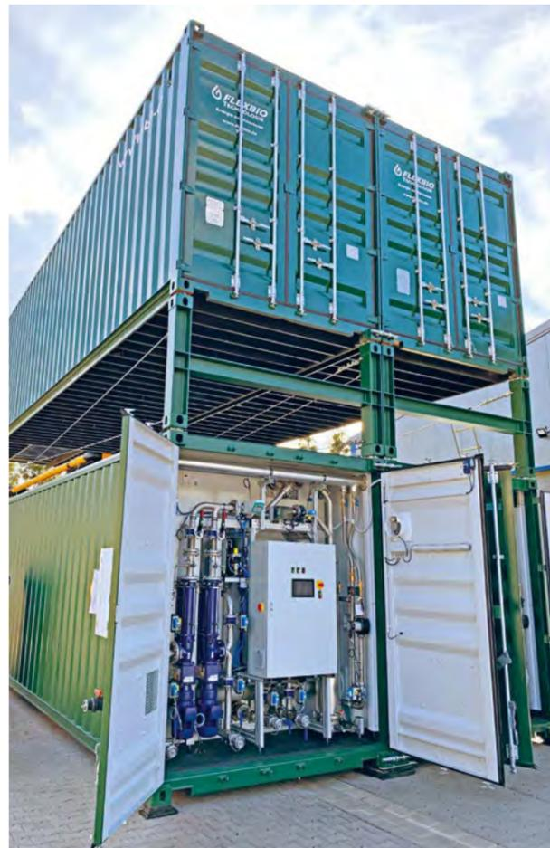
Die Containerbauweise der anaeroben biologischen Abwasserbehandlungsanlagen ermöglicht einen einfachen Transport, eine schnelle Installation und eine modulare Ausstattung.
