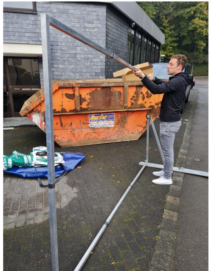
5. Im nächsten Schritt muss die Plane über das Tor gespannt und anschließend mit den vorhandenen Klettverschlüssen fixiert werden.
