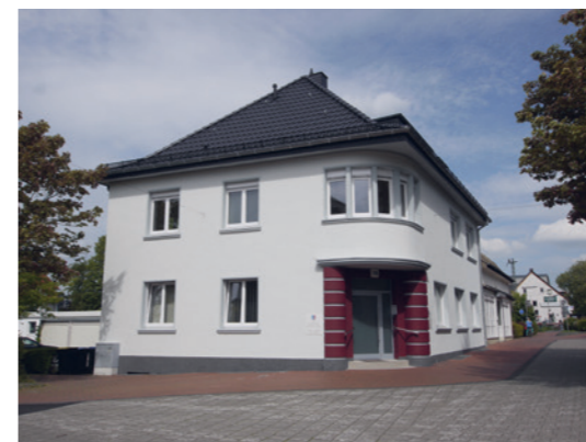
Das Wohn- und Geschäftshaus an der Bahnhofstraße 113 wird im Erdgeschoss zum Jahresende als kardiologische Praxis genutzt.
