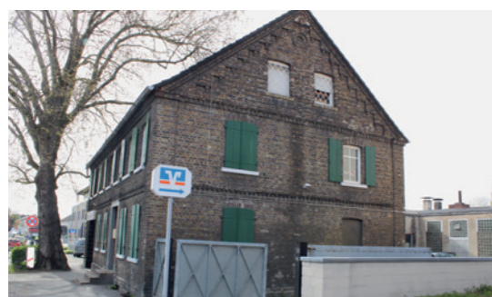
Das Schild weist schon den Weg: Neben der Fleischerei Jokiel entsteht die neue Zuwegung auf den Parkplatz.
