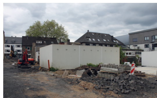
Die Zufahrt zieht sich wie ein Schlauch an der Außenseite des Grundstücks entlang.
