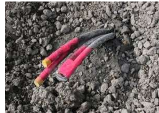
Oberes Ende einer Erdsonde
