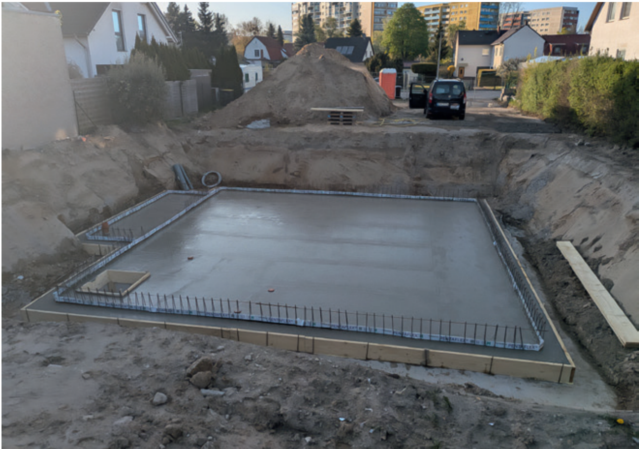
Die Fundamentarbeiten sind abgeschlossen – der Bau in vollem Gange
